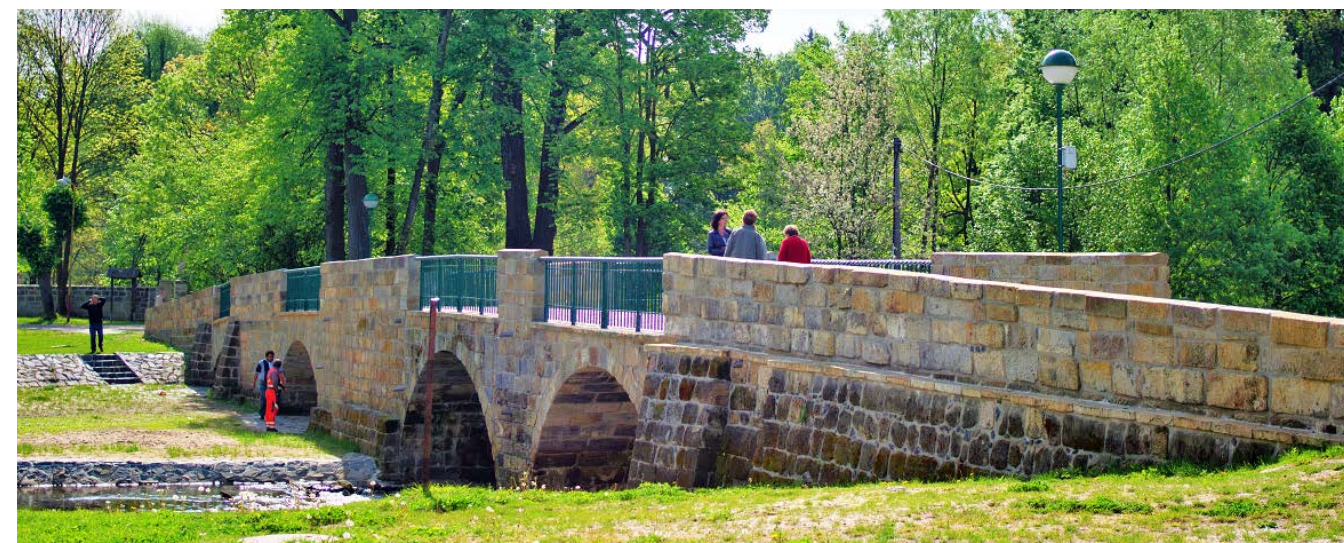
Rekonstrukce Zámeckého mostu včetně úpravy nátoky vodního toku Ploučnice
